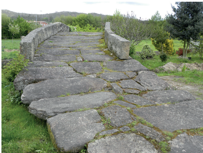
Ponte de Augapesada |
