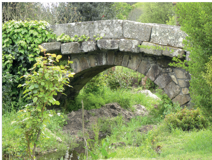
| Ponte de Augapesada
