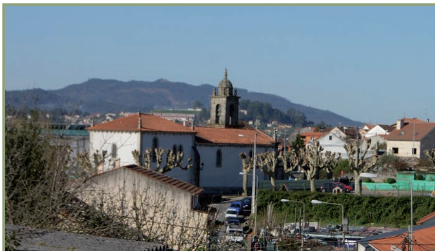
Foto 04: Zona central da aldeia da Bagunda, onde se sitúa a igrexa parroquial de Santa Cristina de Lavadores desde o século XIII. Á dereita da igrexa vense as casas da subaldeia da Ceboleira, que ocupa parte do antigo igrexario dos abades de Lavadores. Ao fondo destacan os míticos montes do Maíxo e Peneites, que separan o Val do Frasco do Val Miñor: aquí de Peneites é Vigo; alén de Peneites, Nigrán. Obsérvanse os canzorros románicos conservados por ducias baixo o tellado da igrexa.
